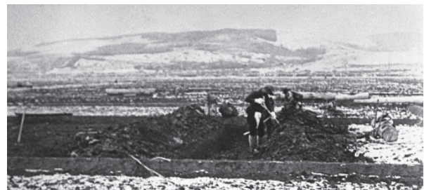
泥土が浅い部分はトロツコで搬出して除去、深い部分は埋もれた良質の土壌を掘り上げ、ここに泥流土を埋めて、上部を良質土壌で被覆(反転客土)
